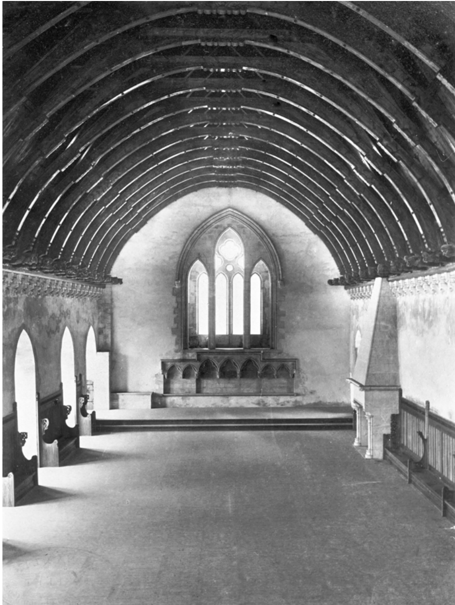
FIGUR 6: Interiøret i Håkonshallen som viser den åpne takstolen. Bildesamlingen, Universitetet i Bergen.
